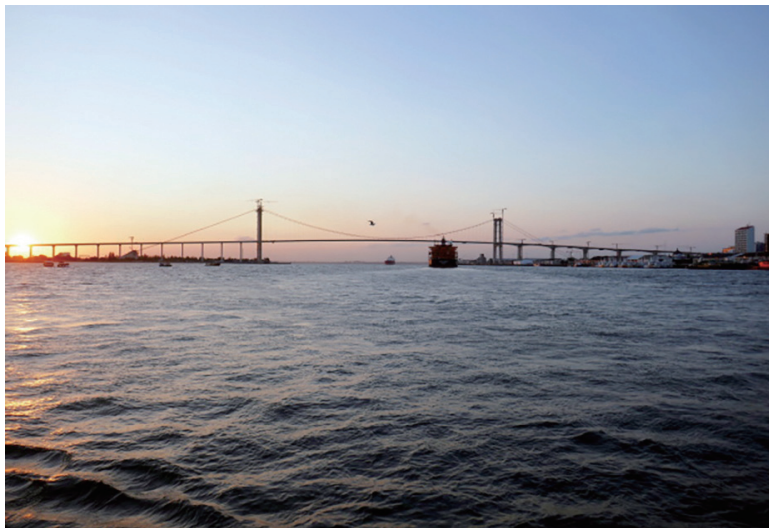
中国路桥承建的马普托跨海大桥是目前非洲最大的悬索桥
