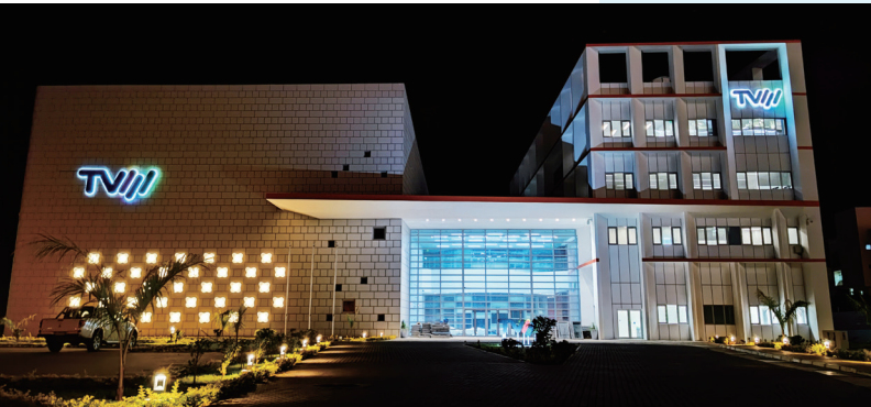
我们承建的莫国家电视台新楼
